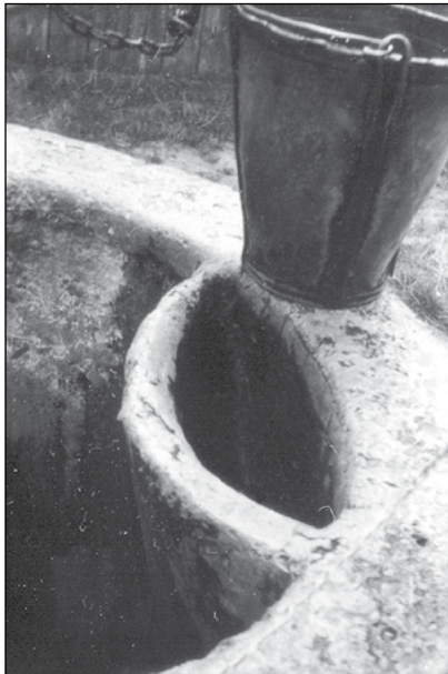
1. Beton kútcalácson kialakított vízkiöntő (Lészped, 1995)
