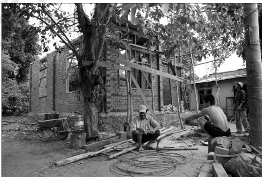
8. Az épülő új ház
