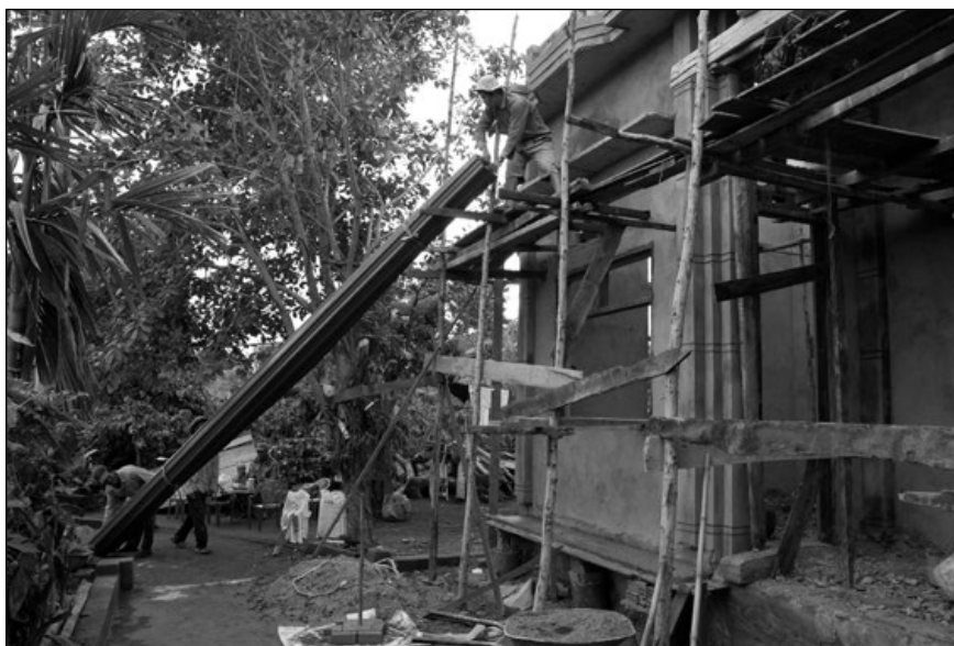
9. A hullámbádóg tető felrakása
