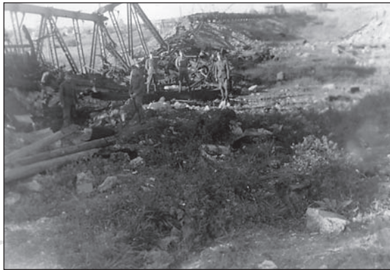
9. kép. Felrobbantott híd
