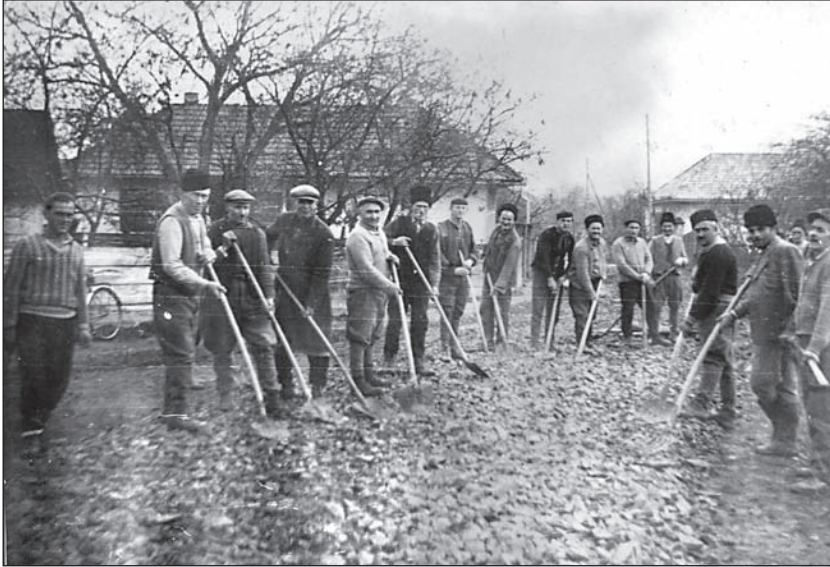
3. kép. Útépítési közmunkán
