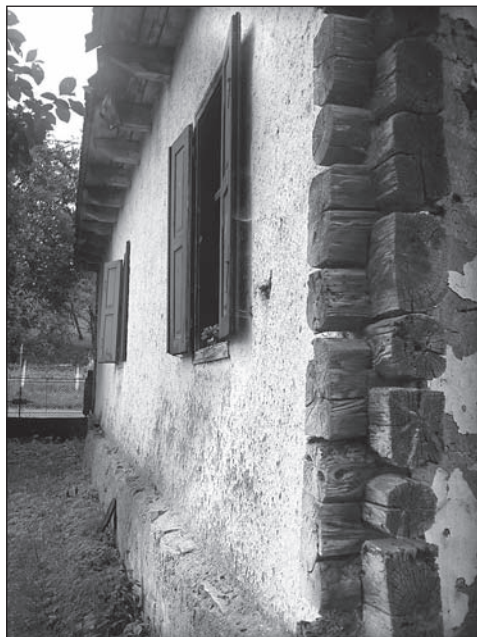
3. kép. Keresztvéges illesztésű boronafal (2009. július, Törő Balázs felvétele)
