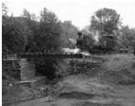
A Sikló Egyesület és Georg Hocevar által újjáépített Hankó-híd terhelési próbája. 2004. május 24.
