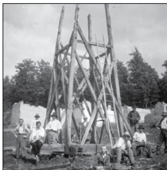
98. kép. Harangláb felújítás közben. Bábony (Szilágy megye), Kós Károly felvétele, 1949 (KJNT Fotóarchívuma 00119)
